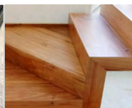
ENTREPISOS, ESCALERA Y BARANDAS
