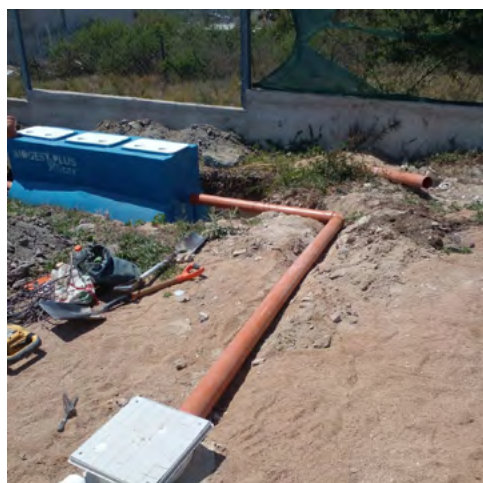
INSTALACIÓN DEL SISTEMA
