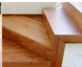
ENTREPISOS, ESCALERA Y BARANDAS
