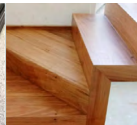
ENTREPISOS, ESCALERA Y BARANDAS
